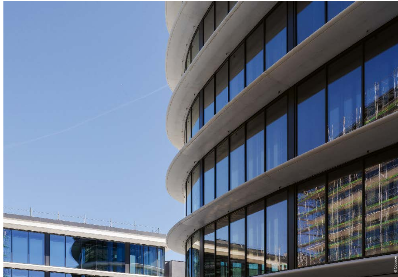
Le léger porte-à-faux des dalles accentue le caractère linéaire des bâtiments et génère une perception de flottement.
