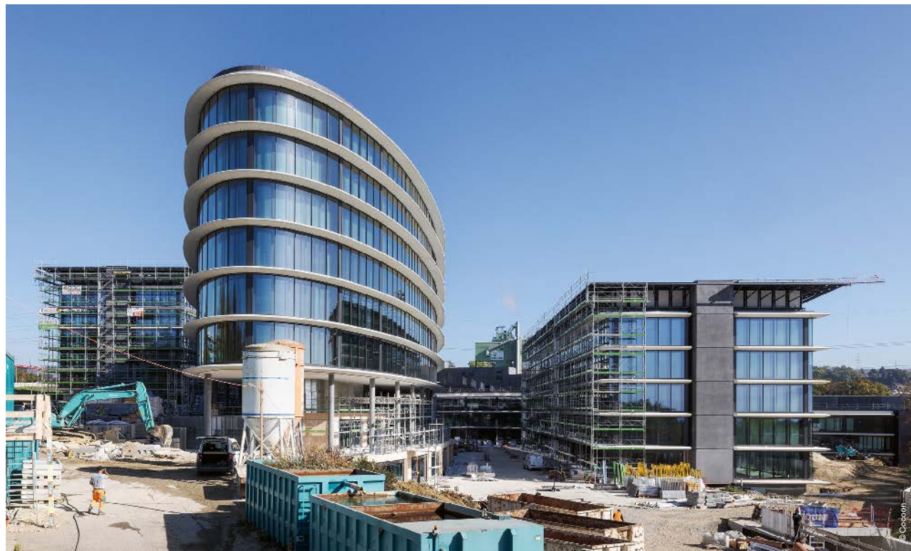
La façade massive et minérale se trouvant le long de l'autoroute dissimule des constructions caractérisées par le verre et la légèreté.
